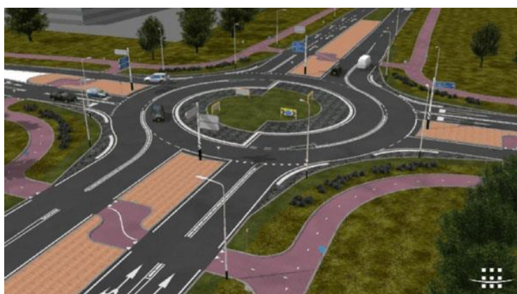
9. ábra: Egy tipikus turbó körforgalom látványterve (Forrás: www.delmagyar.hu/forum )
