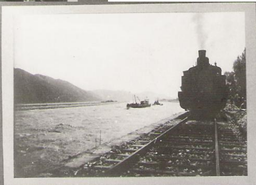
Teilansicht von der Treidelbahn.
